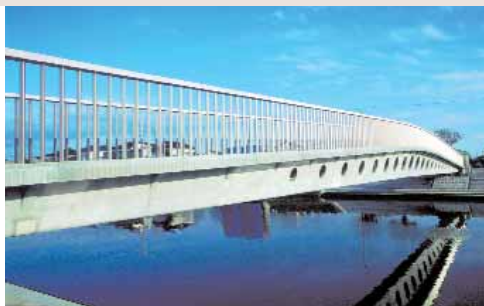
La passerelle Sakata Mirai au Japon : aucune armature passive pour cette passerelle d'une travée de 50 m de long, de 2,4 m de large et un tablier de 50 mm d'épaisseur.
