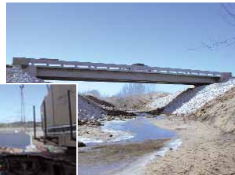
Le pont test de Wapello County dans l'Iowa, 3 poutres d'une portée de 33 m : une simplicité de mise en œuvre réduisant considérablement les coûts.
