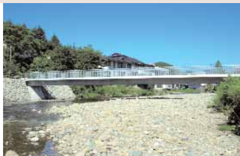
La passerelle de Yokemuri est constituée d'une travée unique de 35,30 m. La section transversale en forme de caisson, a une hauteur constante de 0,95 m et une largeur totale de 3,50 m. Les propriétés de durabilité du Ductal® permettent de résister aux conditions climatiques difficiles de la région.
