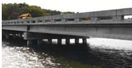
Pont Cat Point Creek Virginie (Etat-Unis)
