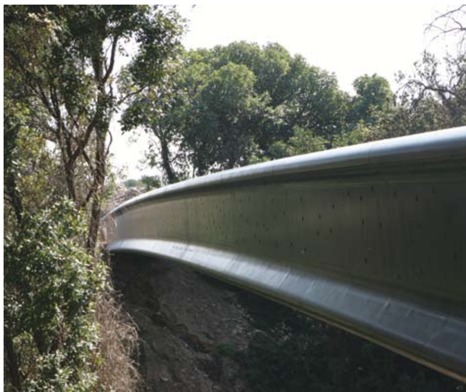
Passerelle du Pont du Diable Architecte : Rudy Ricciotti
