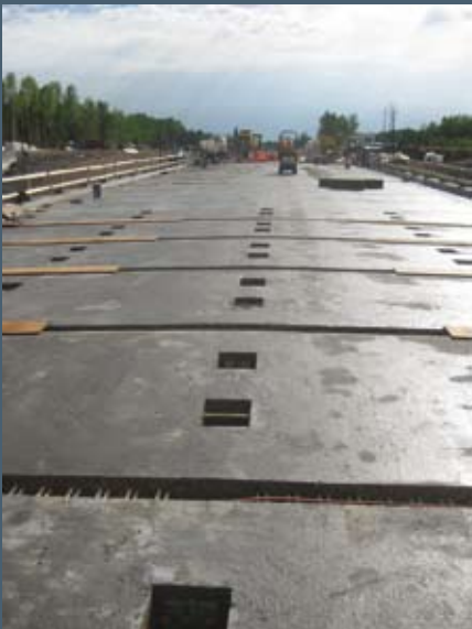
Tablier de pont préfabriqué prêt pour le "joint fill".
