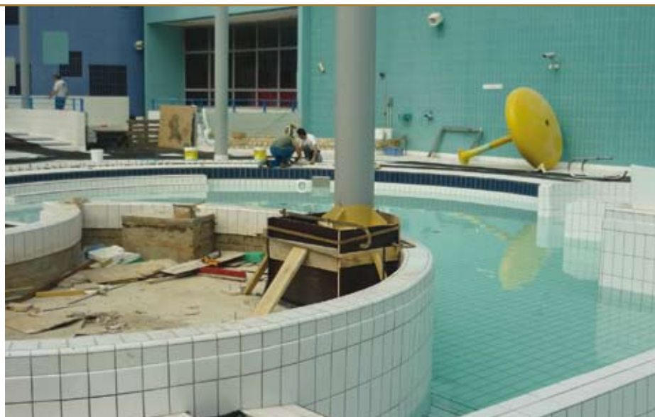
Poteau rénové en bord de bassin.
