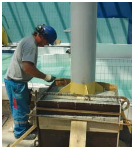
Rénovation avec du Ductal® d'un poteau métallique fortement corrodé en pied.
