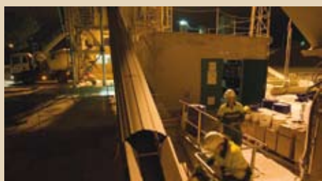
Fabrication en centrale à béton et mise en place du Ductal® autoplaçant.
