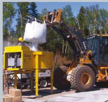
Mélange du Ductal® sur site.
