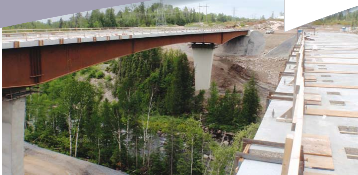
Les ponts jumeaux sur le fleuve Mackenzie près de Thunder Bay, au Canada : le plus grand projet en Ductal® coulé sur site d'Amérique du Nord.
