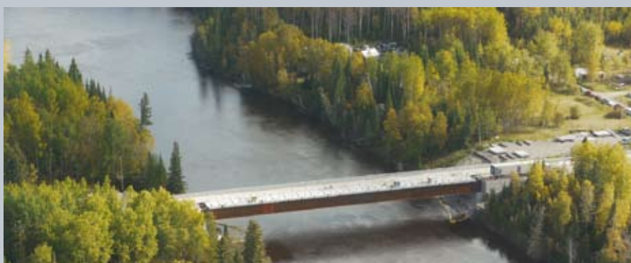
Le pont sur la rivière Chukuni : le plus long pont à travée simple du Canada.
