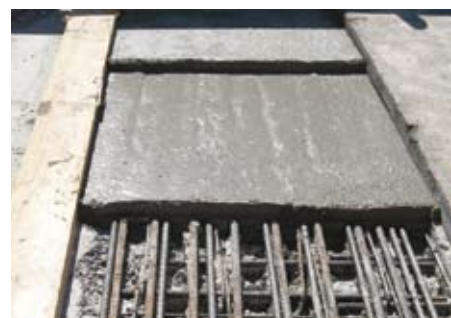
Coulage d'une fine couche de Ductal® assurant renforcement et étanchéité.
